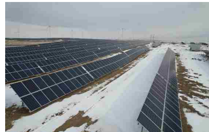
地面电站项目
