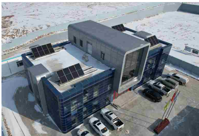
赤城国华碲化镉BIPV幕墙项目
