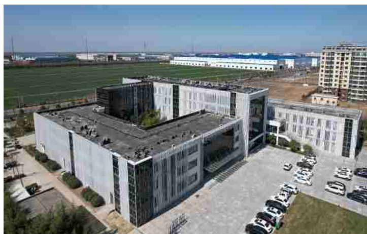
盐城大丰长三角风电产业园项目
